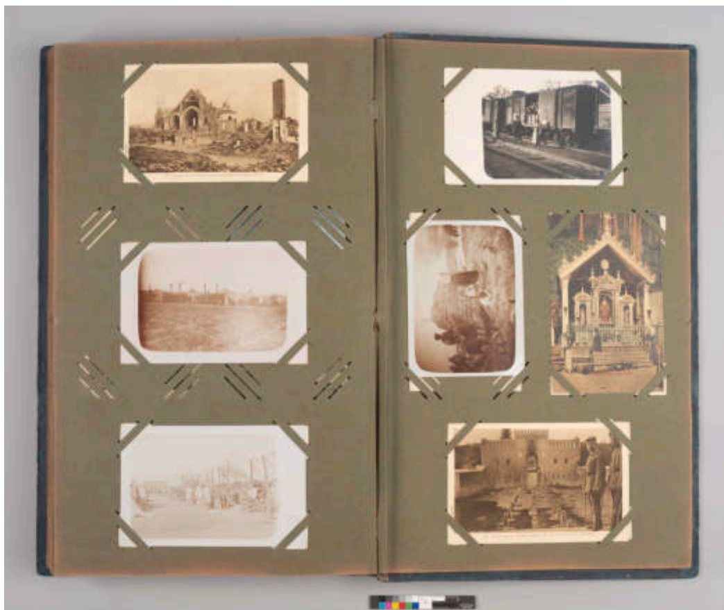
Obr. 47 – 1093/H – Stav diela po reštaurovaní; celkový pohľad – str. 72. a 73.
