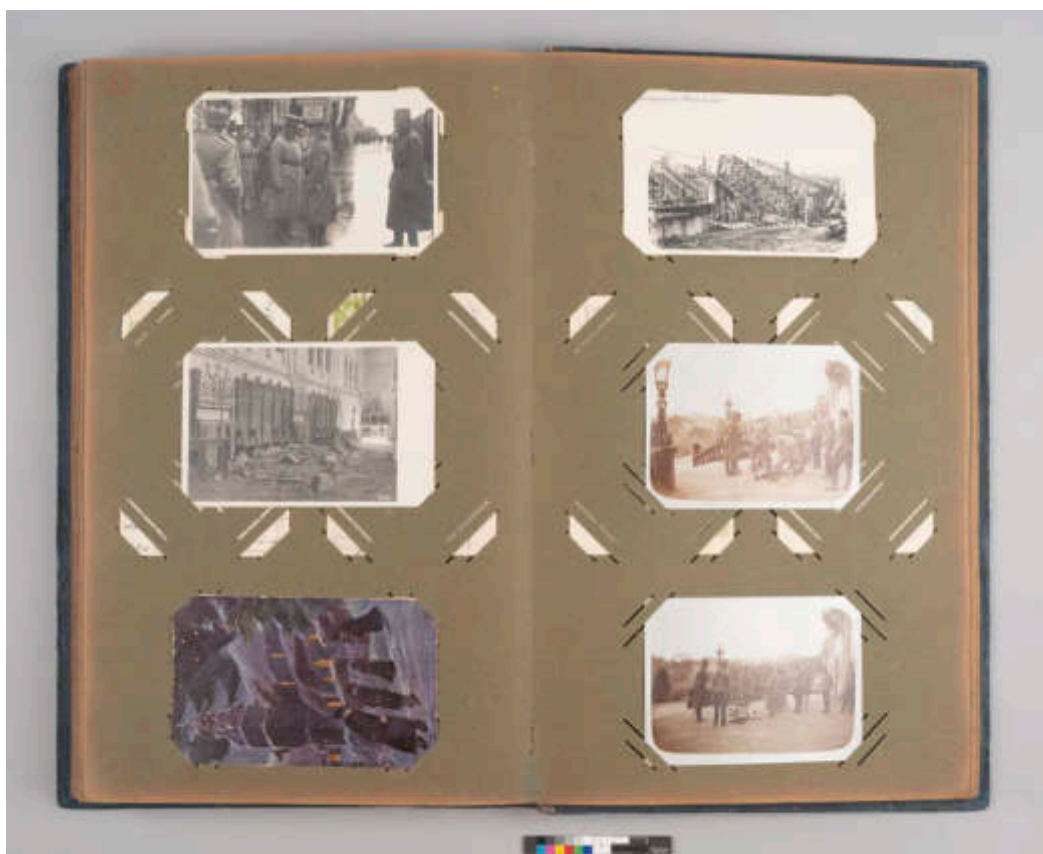
Obr. 42 – 1093/H – Stav diela po reštaurovaní; celkový pohľad – str. 62. a 63.
